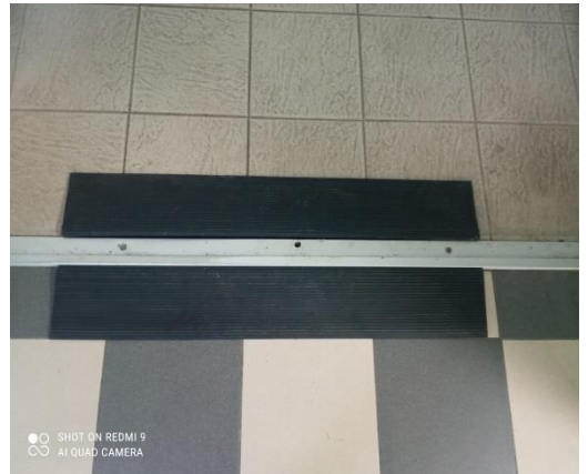
Дверь входная в тамбур ФОТО № 8
